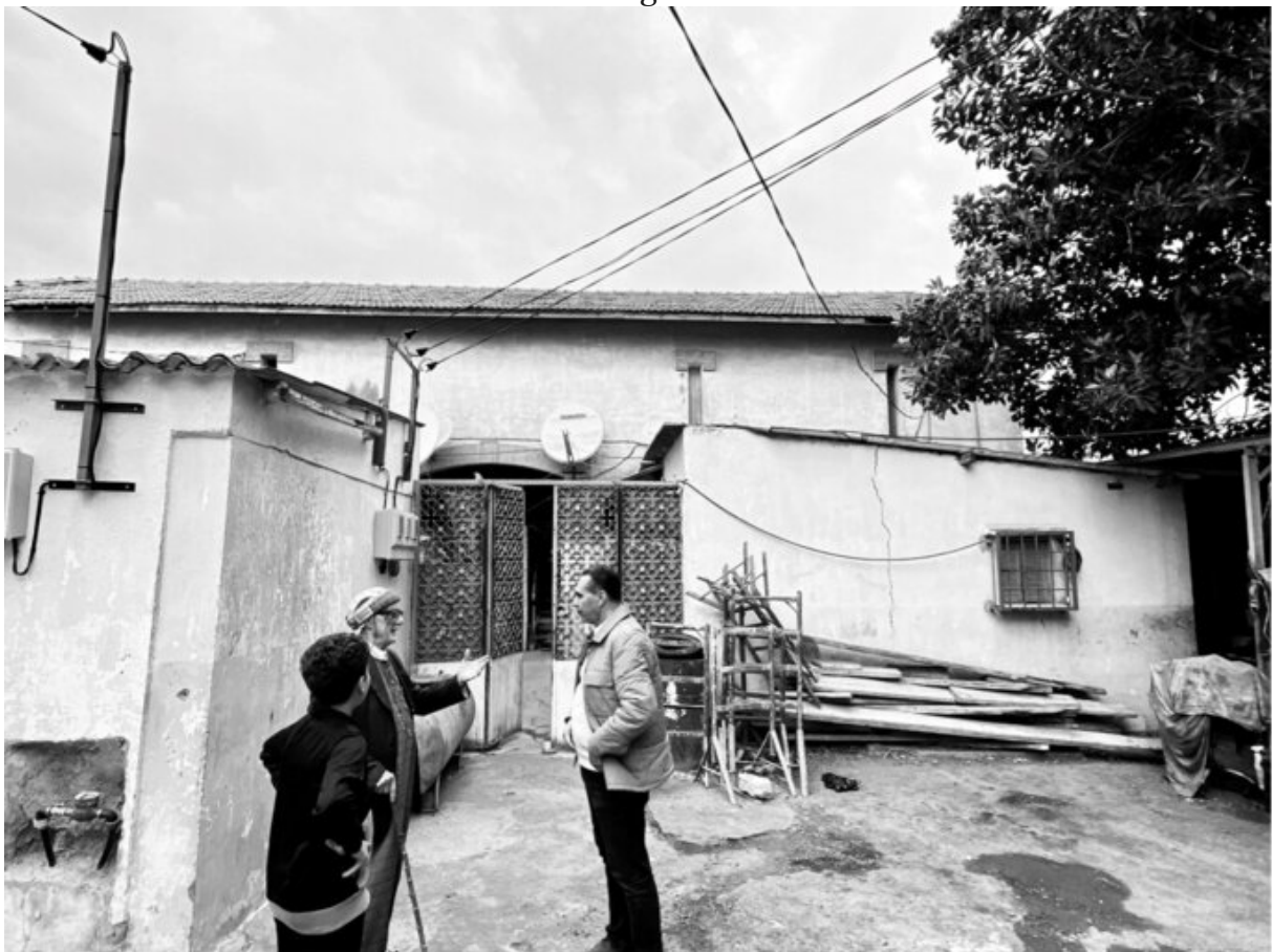
Le bâtiment agricole. © Malika Rahal
